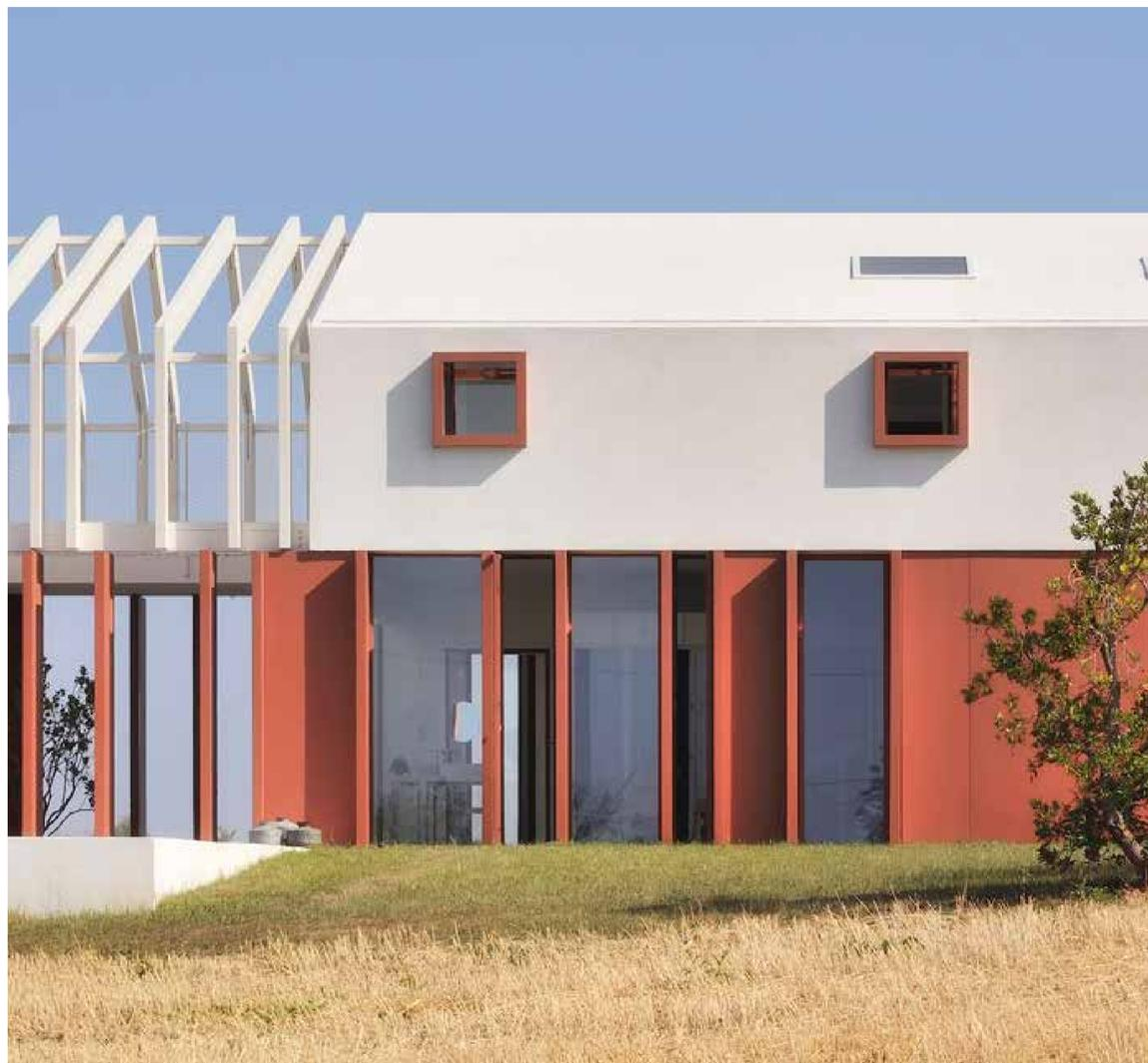
A ESTRUTURA PRINCIPAL, EM AÇO, É PINTADA COM UMA TINTA VERMELHA ANTI-FERRUGEM.
